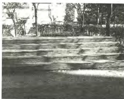
보수 공사 후 나무계단
